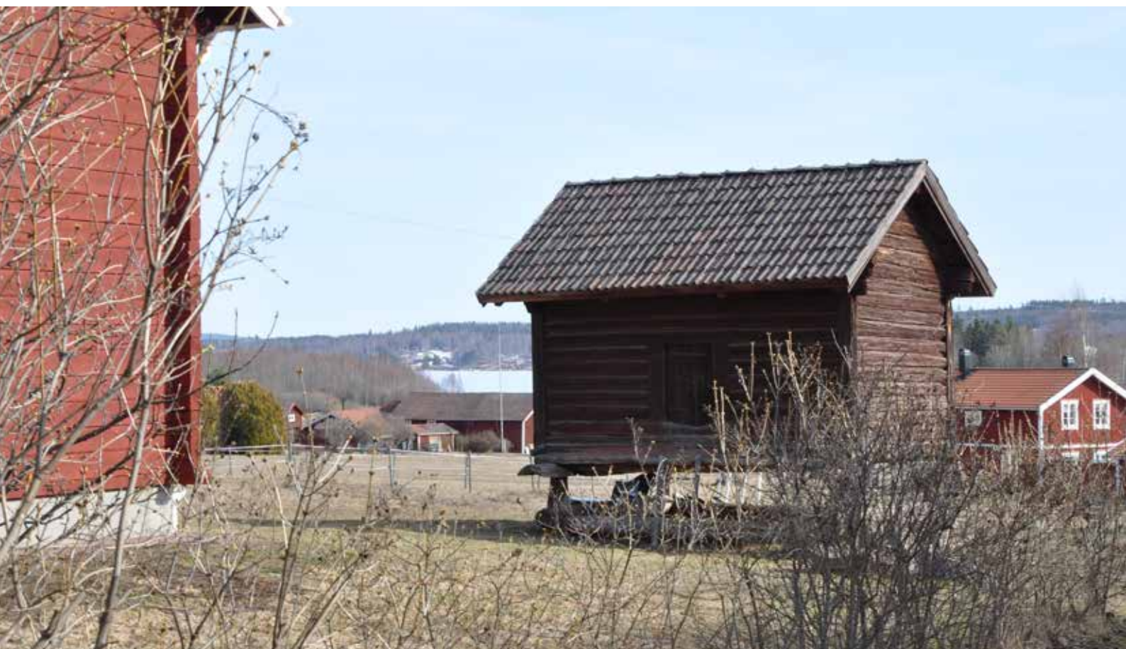
Exempel på ett mycket ålderdomligt långsideshärbre som kan berätta om timmerhuskulturen i äldre tider och därför bedöms ha särskilt kulturvärde. Byggnaden uppfördes 1357. Näsbyggebyn 123:2.
