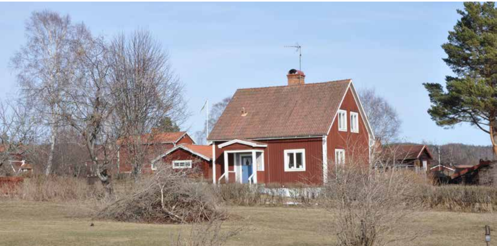
Bostadshus sannolikt uppfört under 1900-talet. Byggnadens form och detaljer är tidstypiska för 1930- och 1940-talen, men byggnaden har anpassats till bymiljön genom färgsättning och proportioner. Näsbyggebyn 38:2.
